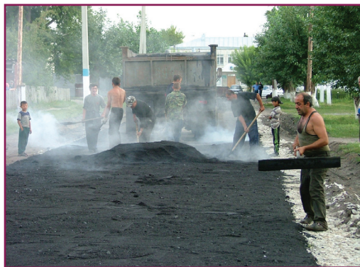
Ремонт дороги ул.Ленина с.Бишкуль
