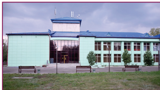
Ремонт фасада Дома культуры с.Бесколь
