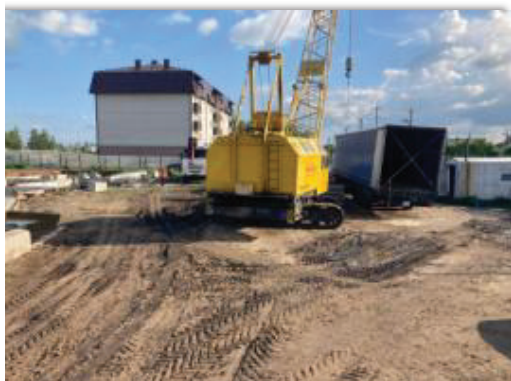
Строительство дома на 50 квартир
